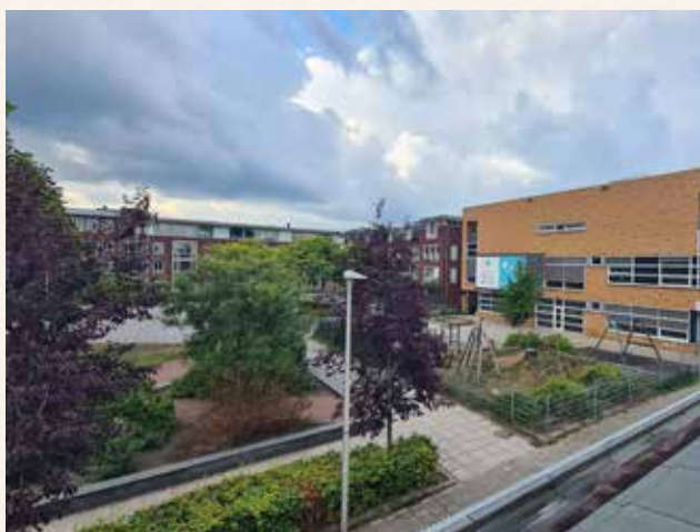
Centrale plein en Daltonschool gezien vanaf dak
